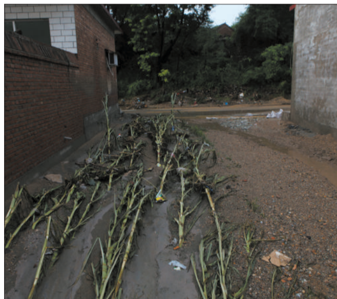
山洪被尾矿坝体抬高后涌向河边的房屋，房屋间的通道成了山洪的泄洪通道，形成激流，高小兰被激流冲走遇难。
