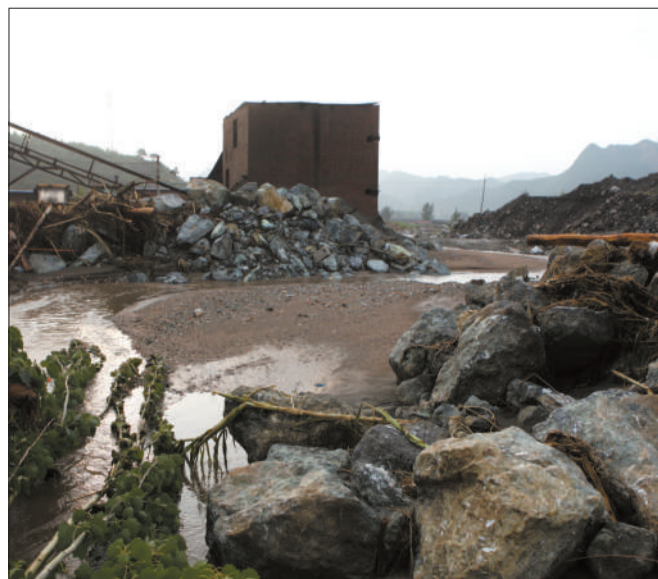
位于王安镇的尾矿矿渣对山洪的拦阻痕迹清晰可见，山洪最终撕开矿渣坝体形成冲击洪流。
