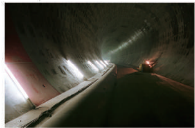
地下输水管距离地面50米,直径达10米,可输送大量雨水。
