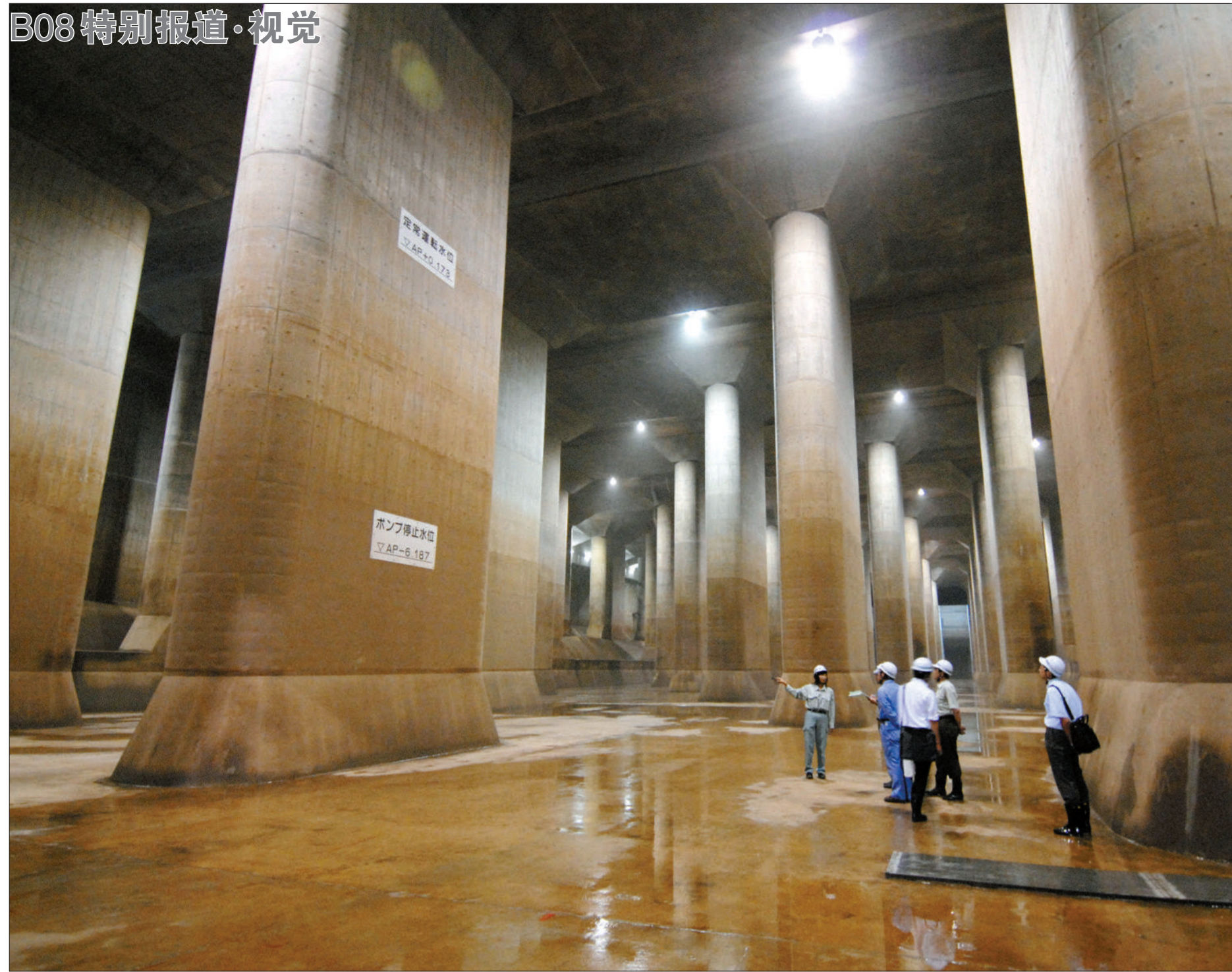
于2006年建成的东京地下防洪排水通道高约25米,长177米,宽78米。
