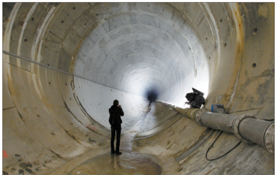
巴黎地下排水管道。
