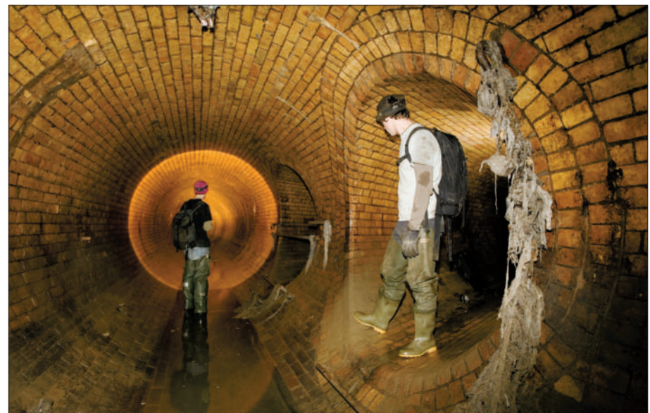
英国伦敦地下排水系统改造工程1865年完工,下水道全长2000公里。
