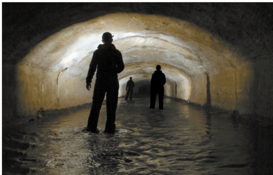
英国谢菲尔德市中心的巨型排水隧道的一部分。该市的排水渠是地下抛物线拱形隧道。
