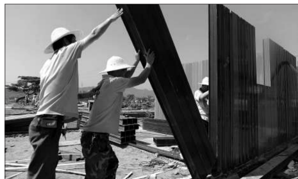
昨日,建筑工人在加紧赶工建安置房。
