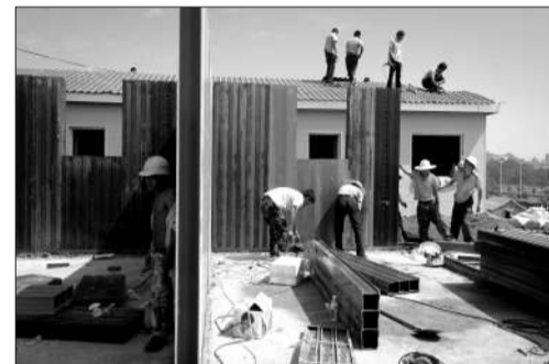
昨日,建筑工人在组装安置房。
