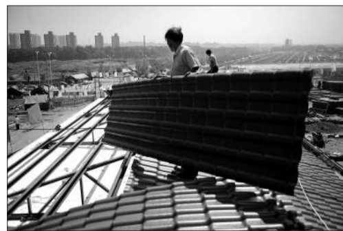
昨日,建筑工人在铺设安置房屋顶。
