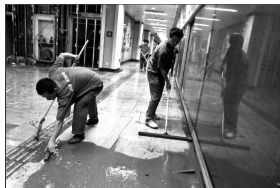
7月29日，抢险人员在遭遇水淹的上海地铁8号线周家渡站进行排水。 图/CFP
