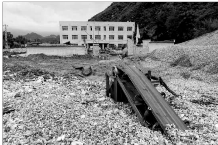
8月1日,涑源县杨家庄镇寺儿庄村附近,一国土资源的办公楼门前留有大量矿渣。
