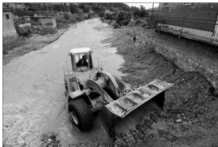
8月1日,涑源县杨家庄镇木吉村,挖掘机在抢修河道。
