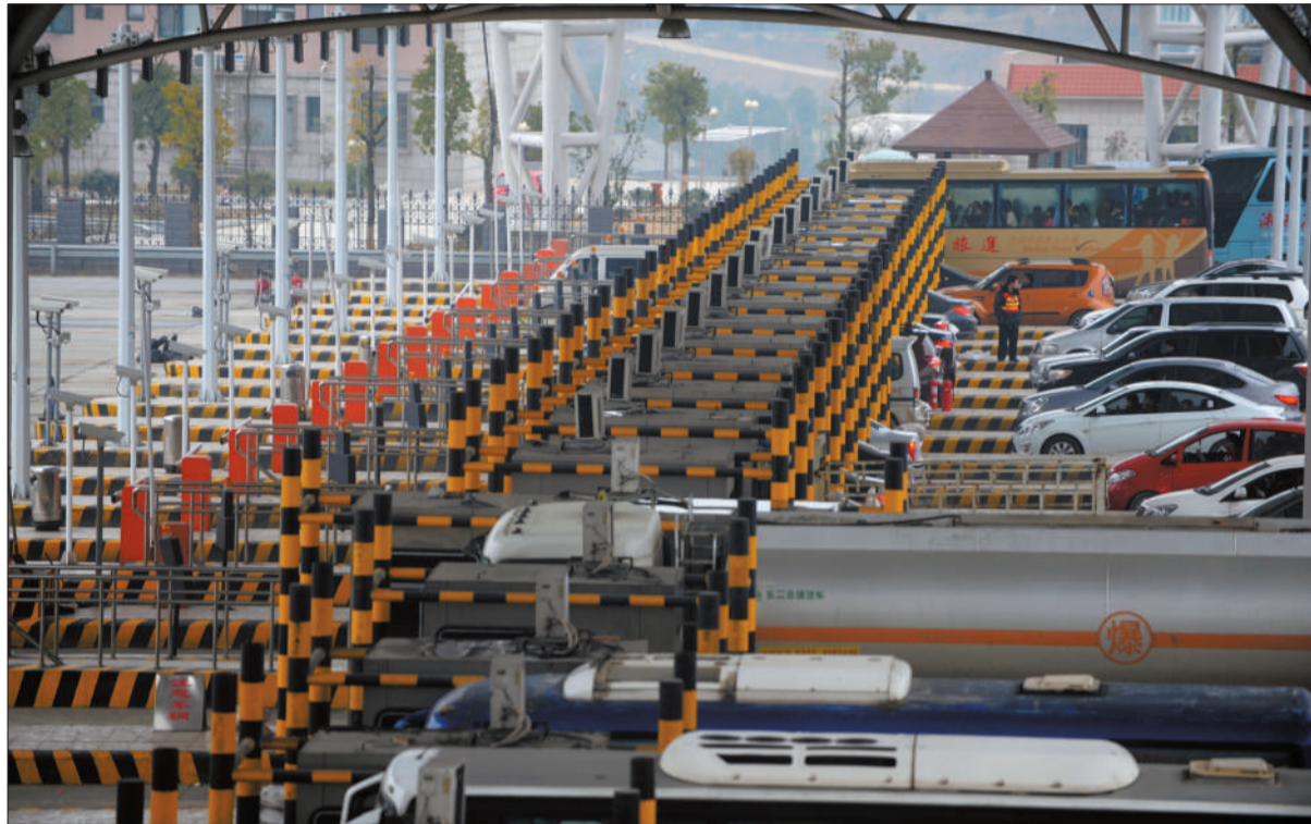
1月28日下午，湖南长常高速公路上的长沙西收费站出站口，为分解过站压力，收费站临时免费放行。
