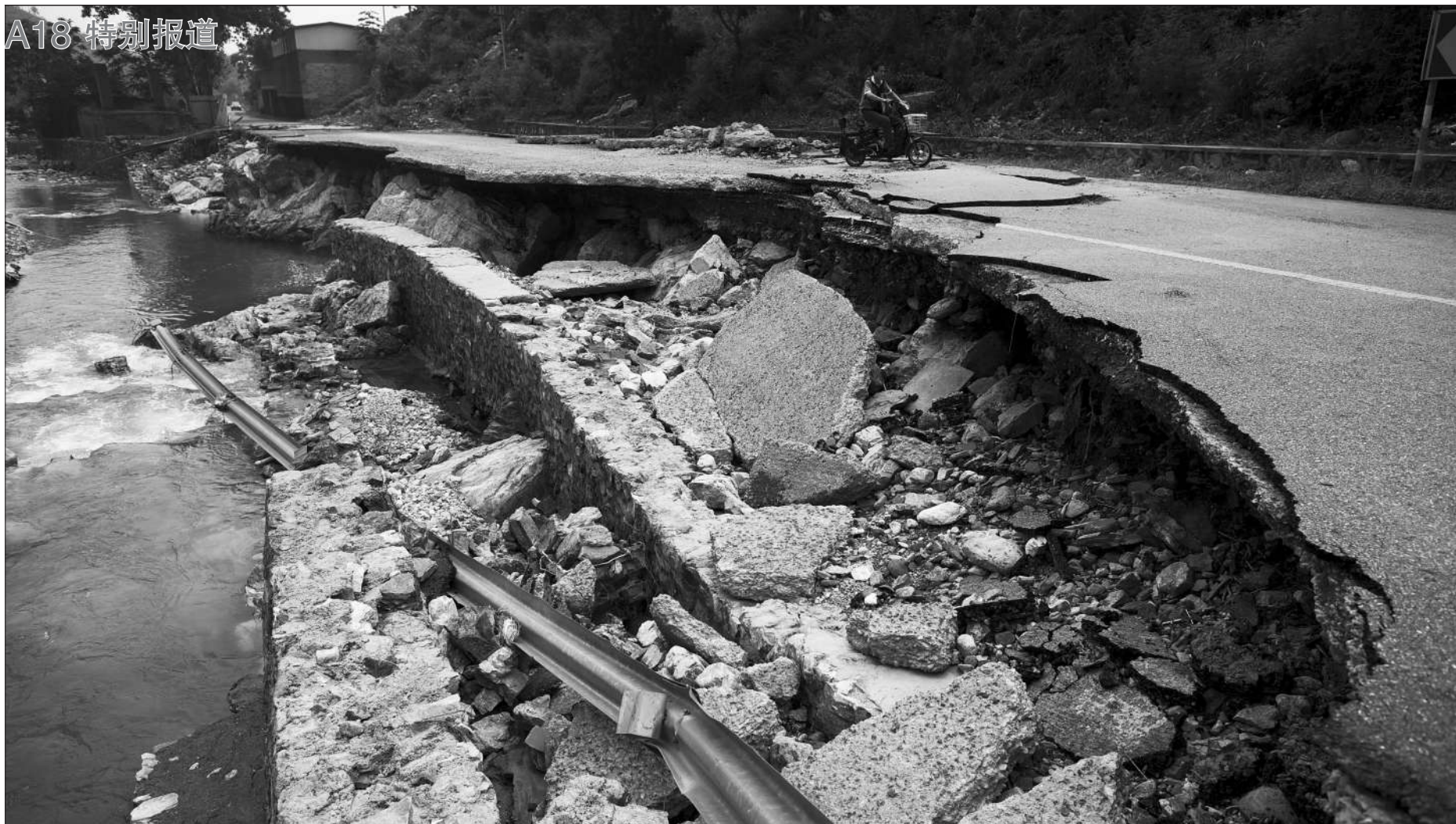
7月25日,从房山区韩村河镇去往圣水峪村的途中,一段道路被洪水冲垮,路基被洪水“掏空”。
