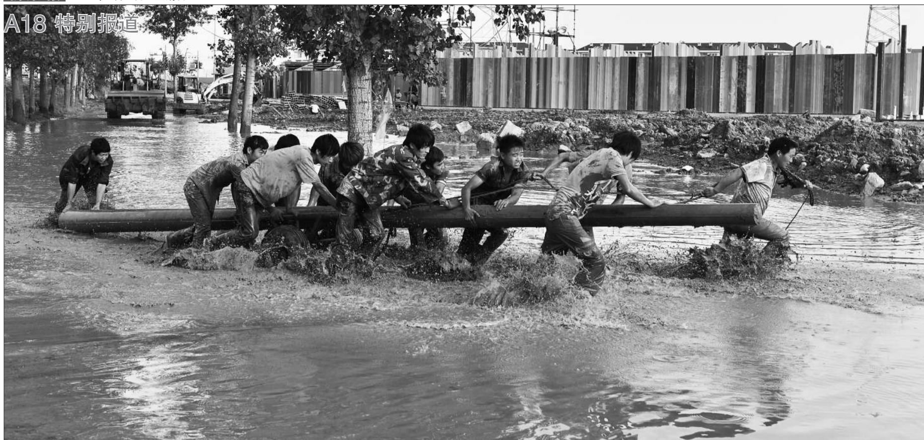
8月2日,在房山区阎村镇公主坟村安置房现场,歌华有线房山分公司的工人们正在水中抢运水泥杆。房山区安置房有线电视布网工程预计最迟今晚完成。
