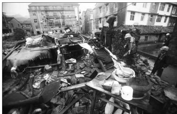
昨日,工作人员在清理童小凤老人倒塌的房屋。当日,浙江宁海一独居老人被转移10分钟后房屋倒塌。新华社发
