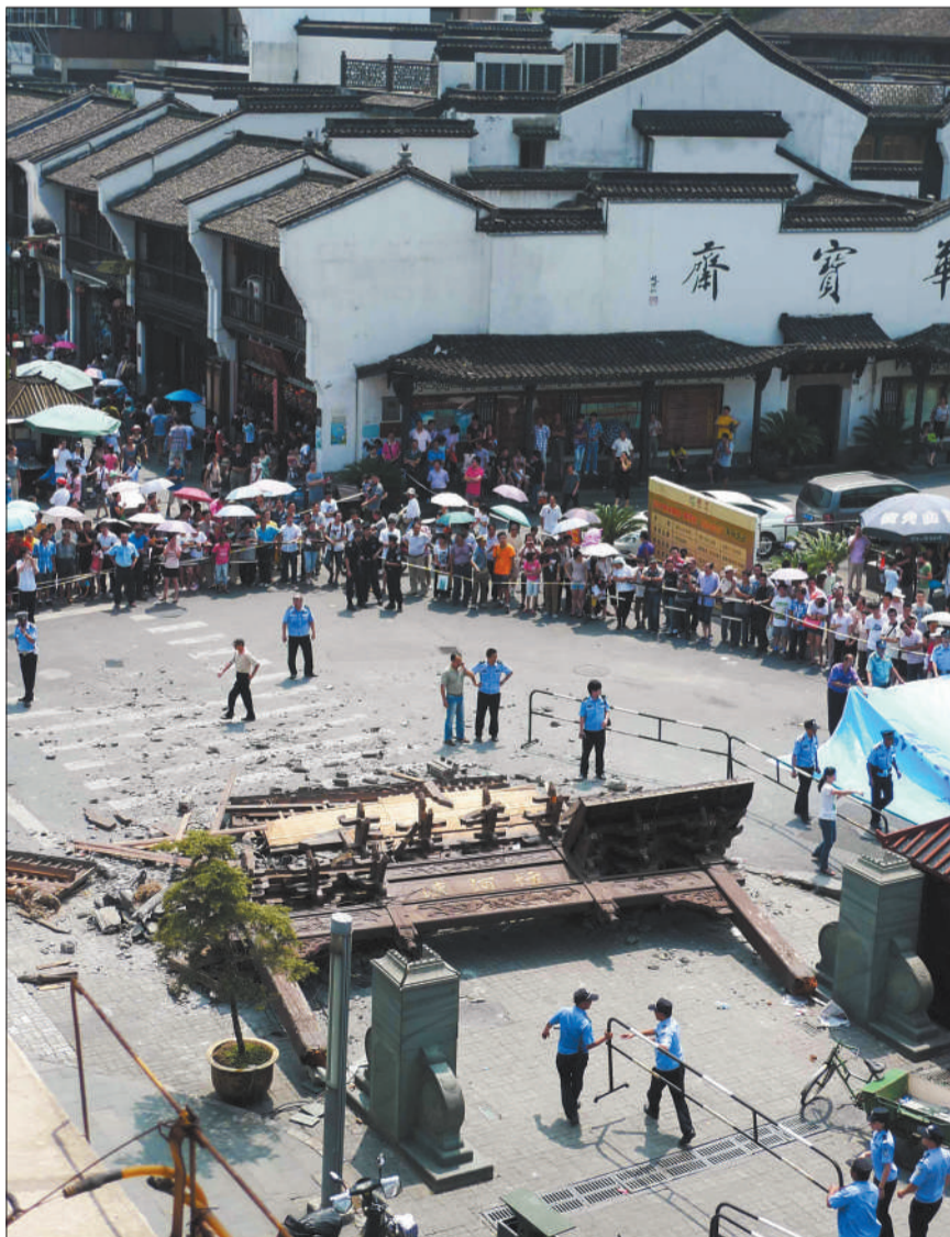
事故现场。昨日上午,浙江省杭州市吴山广场河坊街一座砖木结构牌坊倒塌,造成游客2死1伤。图/CFP
