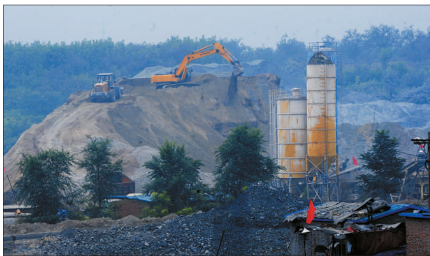
8月8日,常乐寺村村北河道里的一个石料山,挖掘机正在“山”顶作业。
