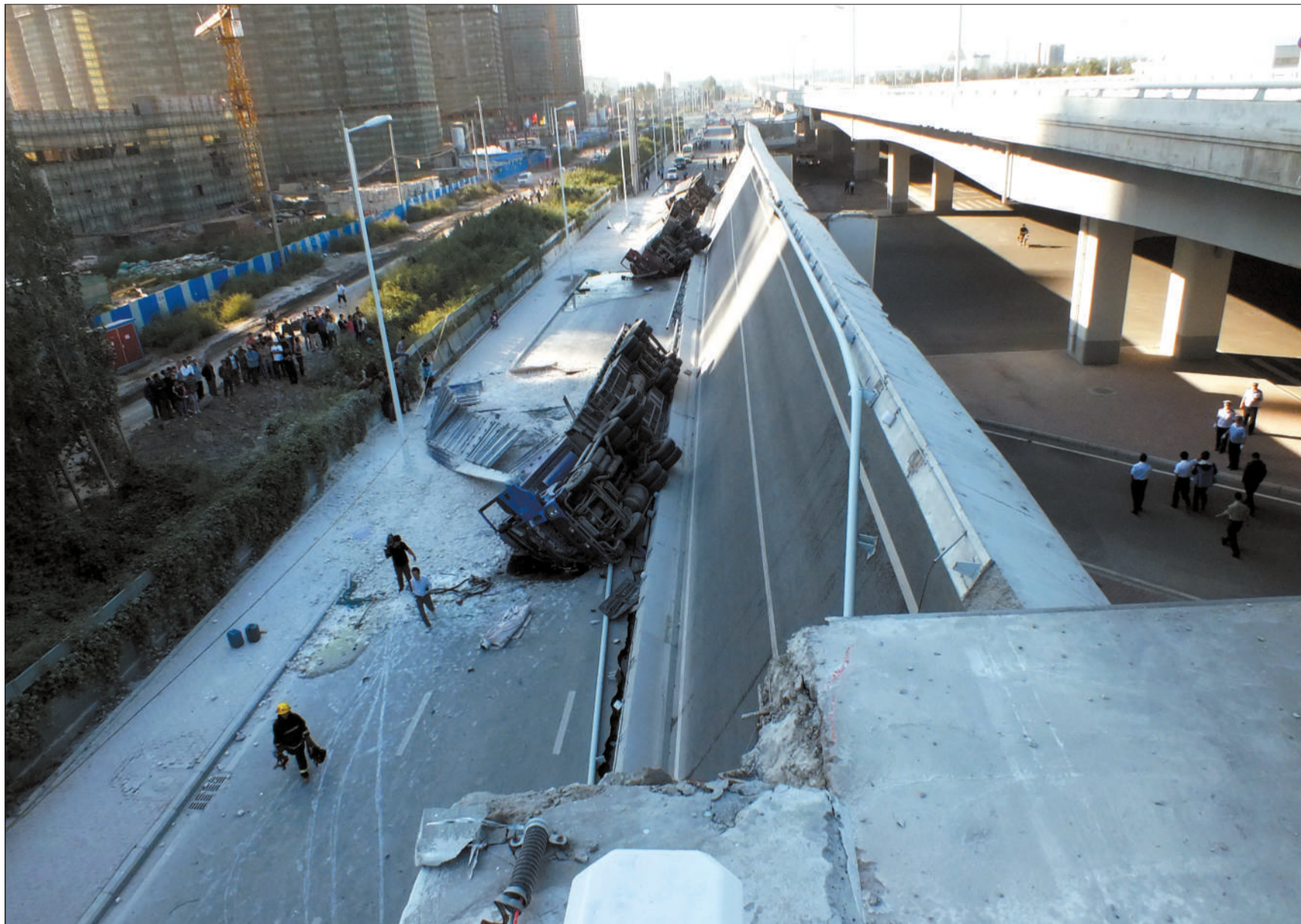
昨日,哈尔滨阳明滩大桥疏解工程、三环路高架桥洪湖路上桥匝道口处(距阳明滩大桥3.5公里)发生坍塌,四辆货车侧翻,导致3死5伤。图/CFP A04-05·热点
