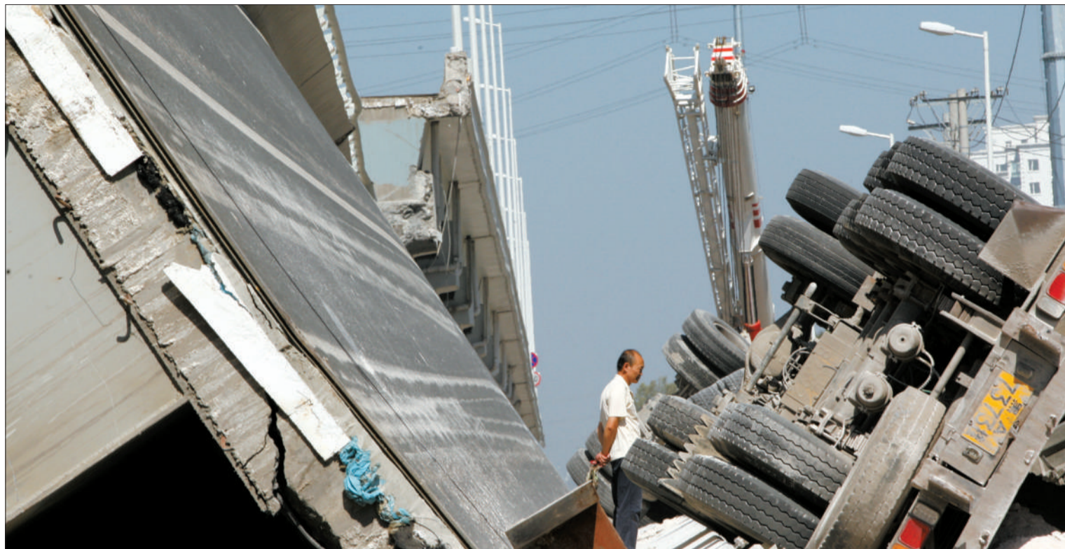
塌桥事故现场。24日，哈尔滨市三环路高架桥洪湖路上桥匝道处（距阳明滩大桥3.5公里）钢混叠合梁侧滑，4辆货车侧翻，造成3死5伤。
