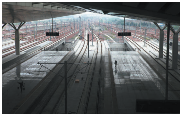
8月15日,高铁郑州东车站台,工人正在施工。
