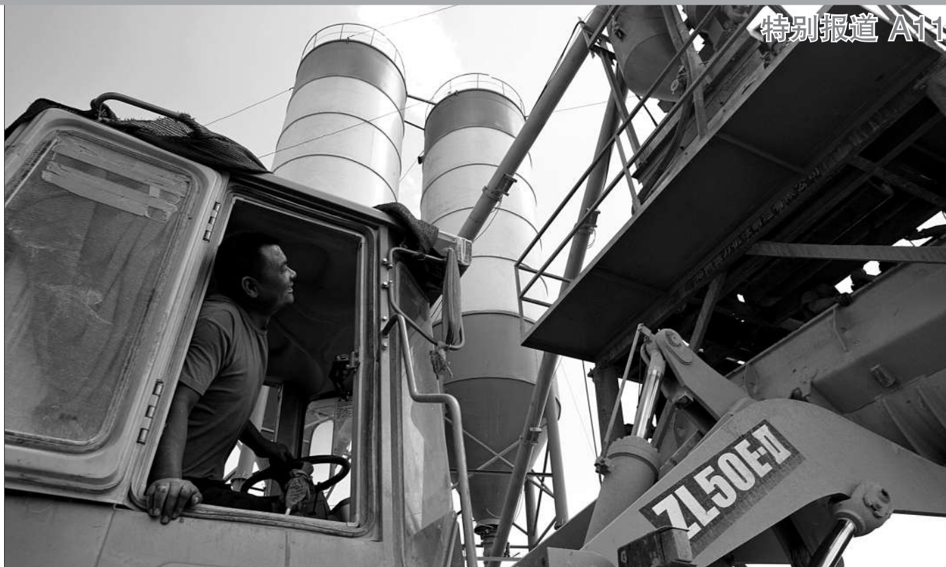
8月18日,新疆哈密戈壁上,负责浇筑站的工人朱向东在水泥罐车内看工人在检修浇筑站的机器。
