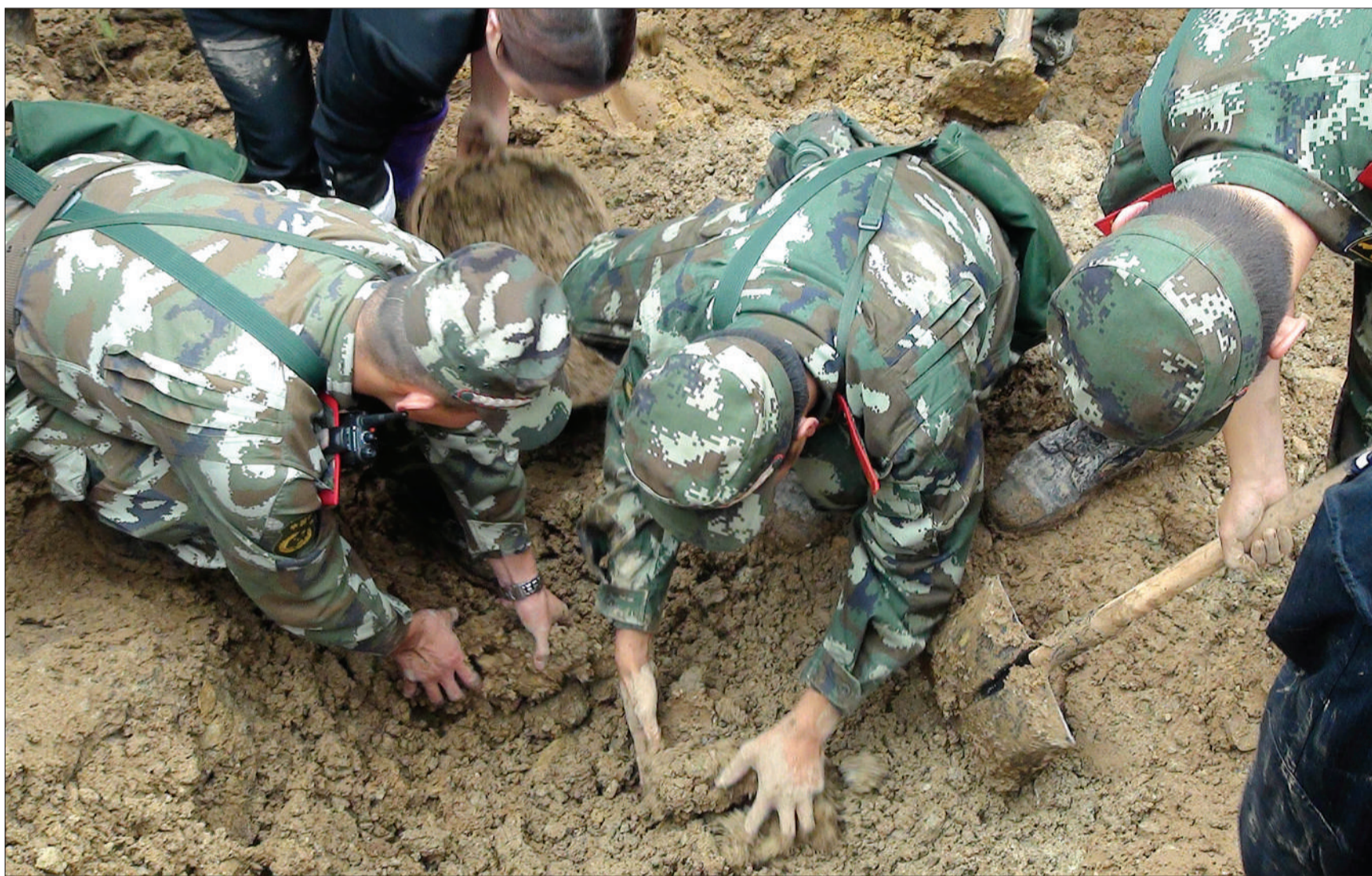
10月4日,武警昭通支队官兵和驻地群众一起在云南彝良山体滑坡现场挖掘被压埋的人员。
