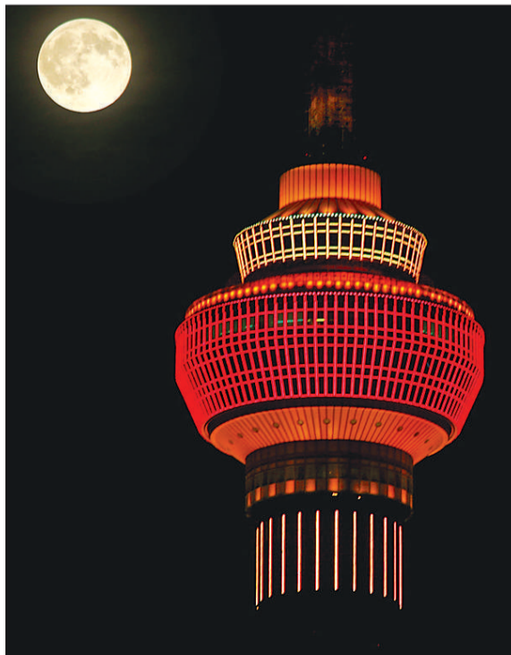
大红灯笼造型的中央电视塔在明月的陪衬中。赵建华 摄
