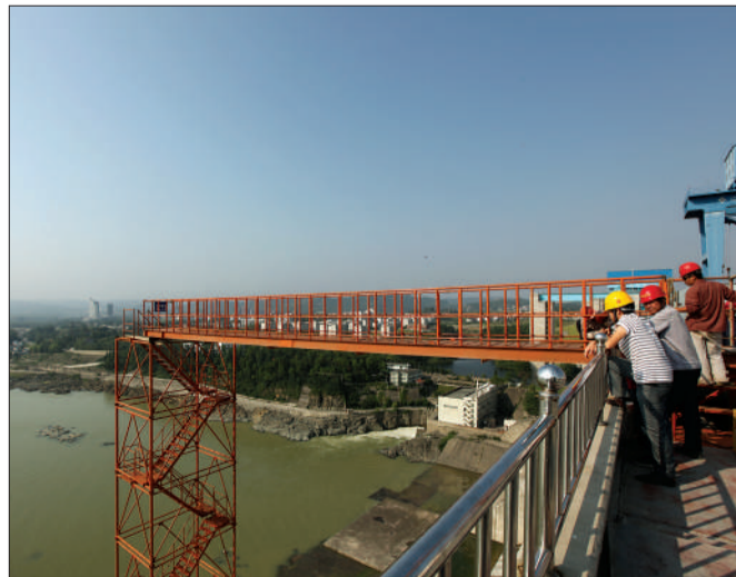
丹江口水库大坝施工人员在工地上小憩。
