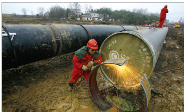
2009年11月17日,湖北随州西二线工程东段,工人们正在施工。
