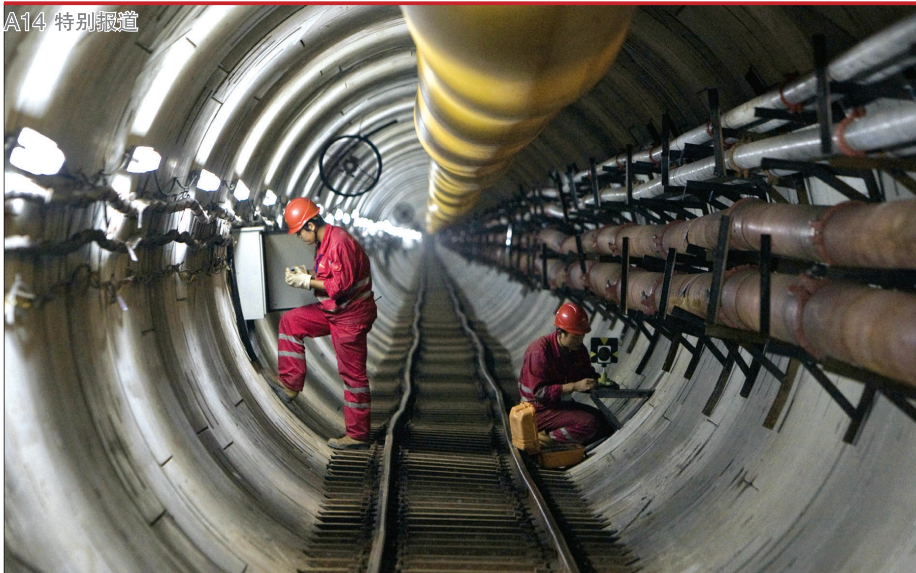
2009年10月11日,江西瑞昌,施工人员在西气东输二线工程长江盾构隧道中检查线路。
