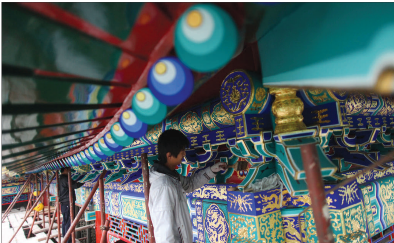
昨日,颐和园德和园大戏楼,一位工作人员正在给屋檐涂油料。目前,德和园大戏楼已修缮完工。
