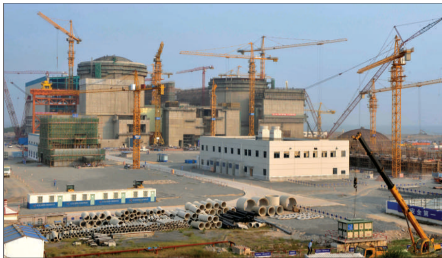
23日，正在加紧建设的广西防城港核电站。
