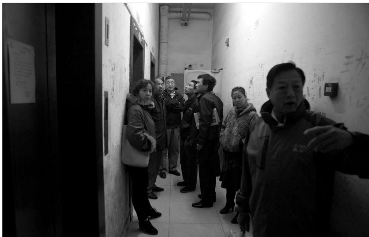
昨日,广渠家园小区11号楼2单元,居民站在电梯前。当日,因热力管爆裂,该单元3部电梯被淹停运。 新京报记者 周岗峰 摄
