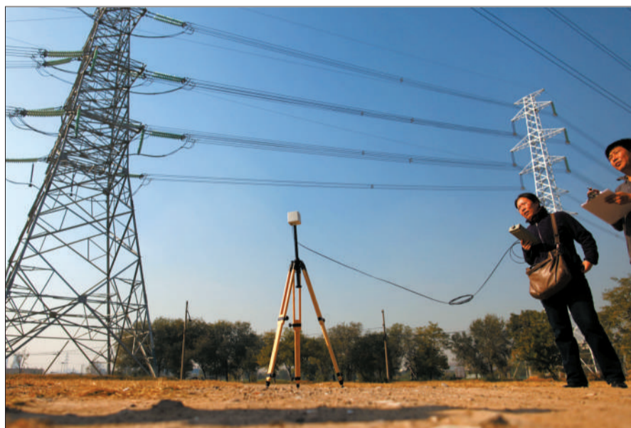
前日,草桥,工作人员在检测一处居民小区附近的高压线塔周围的电磁强度。
