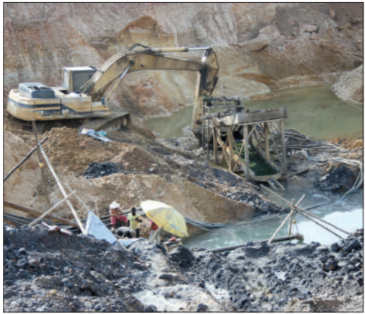
1 挖砂 挖机掘井,搬运金沙。
